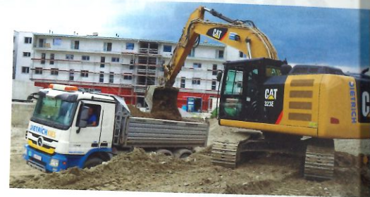
Auch im mehrgeschossigen Wohnbau sind die leistungsfähigen Geräte der Firma Dietrich gefragt. Im Bild ein Cat 323E L, der rund 8.000 m³ Aushub für eine Tiefgarage in Nußdorf-Debant erledigt.
